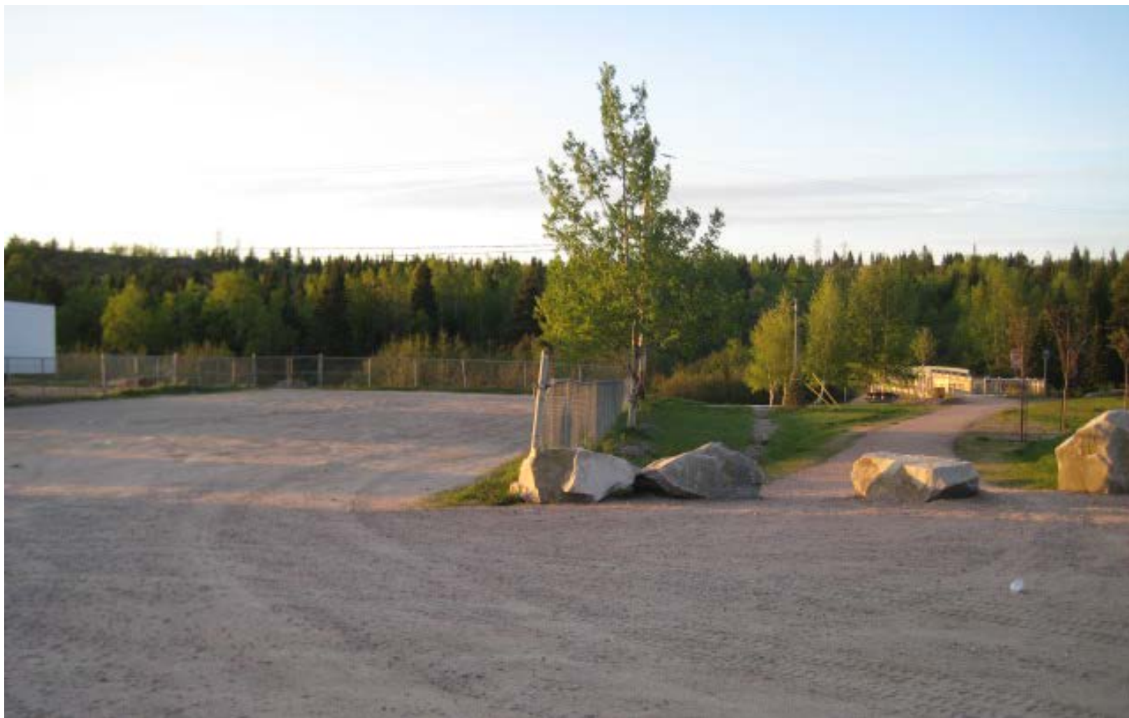
Stationnement, parc et pont du sentier de la rivière Amédée, rue Bossé est
